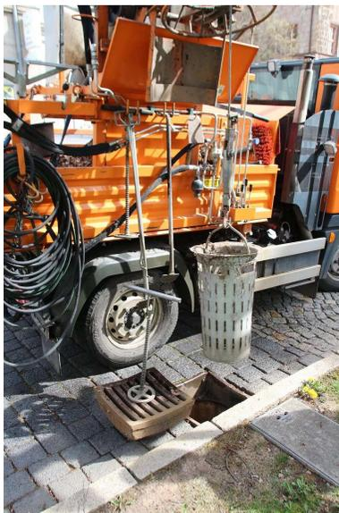
Wartung eines Straßenablaufs Ausführung „Nassschlammfang“
