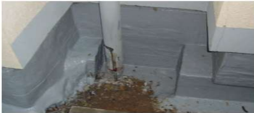
Sonderabdichtung im Bereich des Sockels
