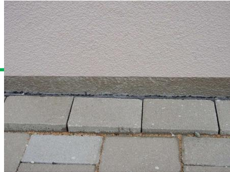
Feuchtebelastung am Sockel minimieren oder Druck abfangen
